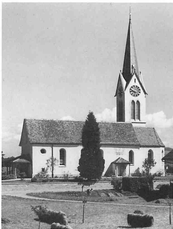
... und 1958, nach der Renovation
