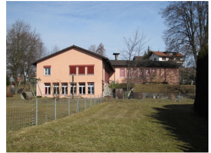
Kindergarten Sunneberg, Wolfhausen
