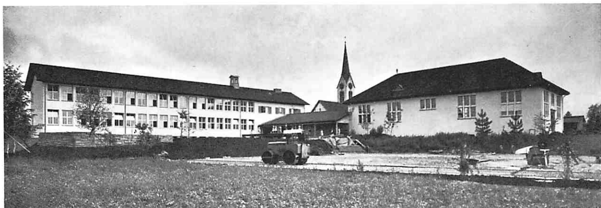
Das Schulhaus «Spycherwiese», erbaut 1953, mit dem Verbindungstrakt zur 1926 erstellten Turnhalle (Aufnahme im Baujahr)
